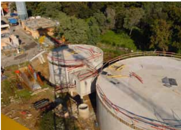
Travaux d'extension et de mise aux normes (2006) - © G. Jacomet
