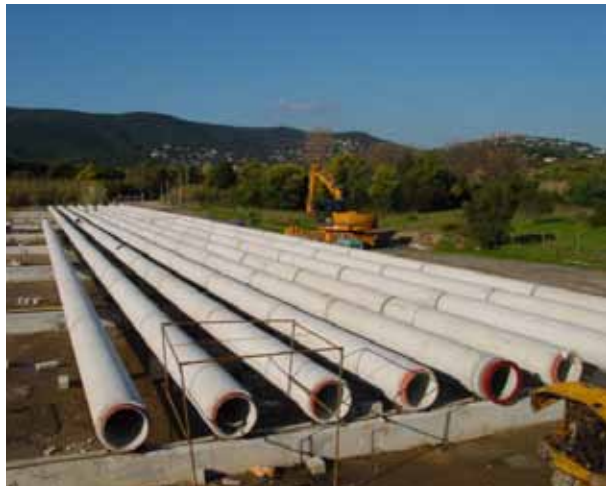
Mise en place en 2001 du nouvel émissaire en mer - © G. Jacomet
