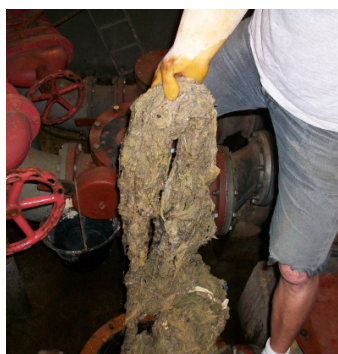
Déchets divers obstruant les réseaux d'assainissement - © G. Jacomet
