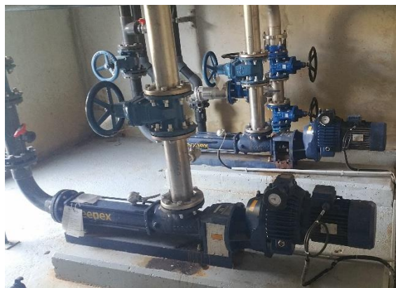
Pompes à boues situées en dessous de l'épaississeur
