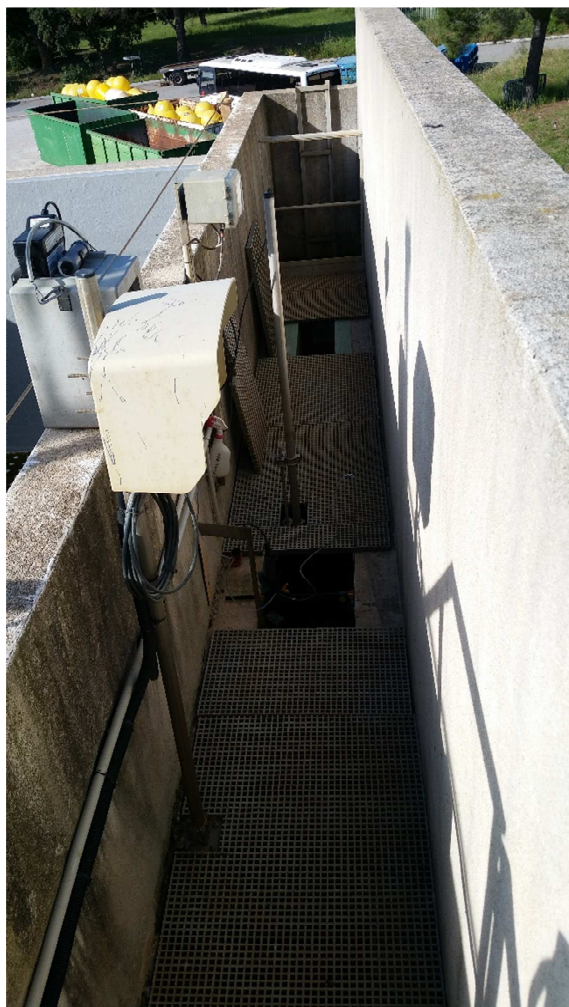
Débitmètre sortie station
