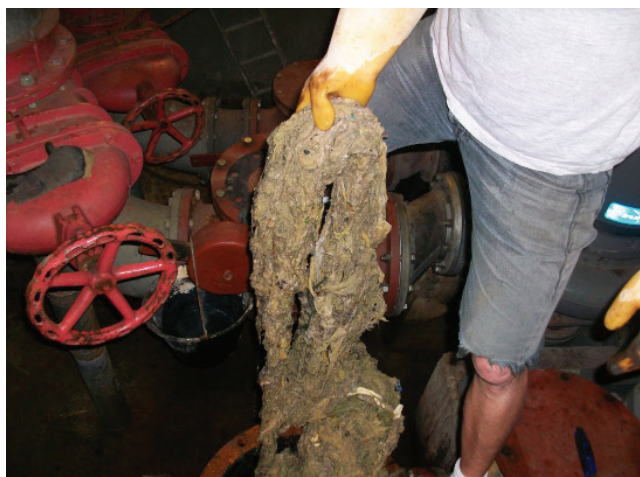
Déchets divers obstruant les réseaux d'assainissement - © G. Jacomet
