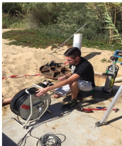
Octobre 2018 Inspection camera de l'émissaire.
